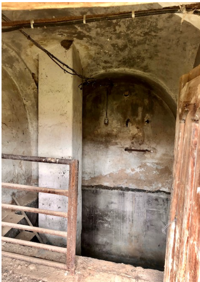
bývalá kotelna – klenutý strop
