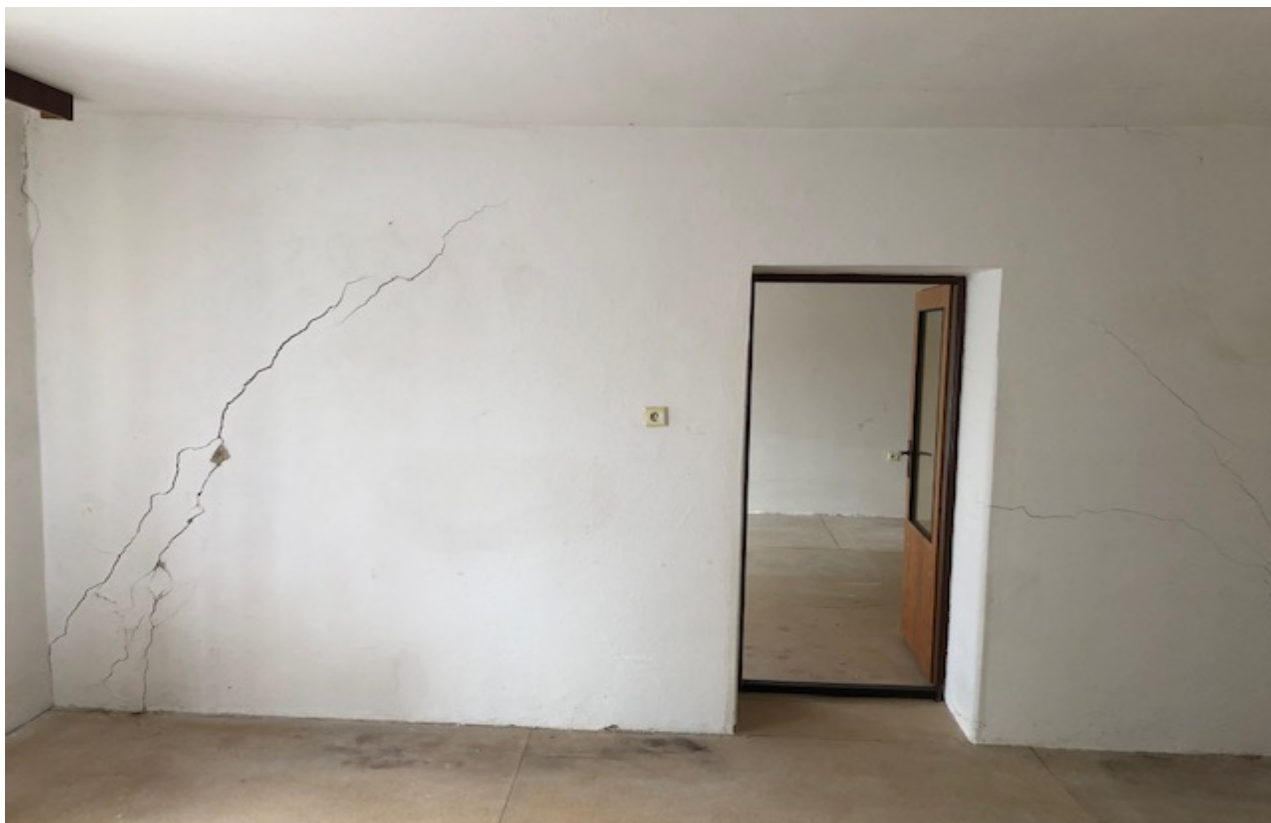
byt 1 – pokoj A – doporučena sanace prasklin zdí (cenová nabídka sanační firmy k dispozici)
