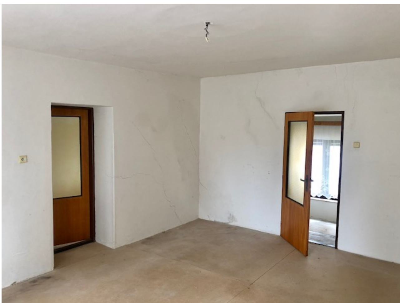
byt 1 – pokoj A – doporučena sanace prasklin zdí (cenová nabídka sanační firmy k dispozici)
