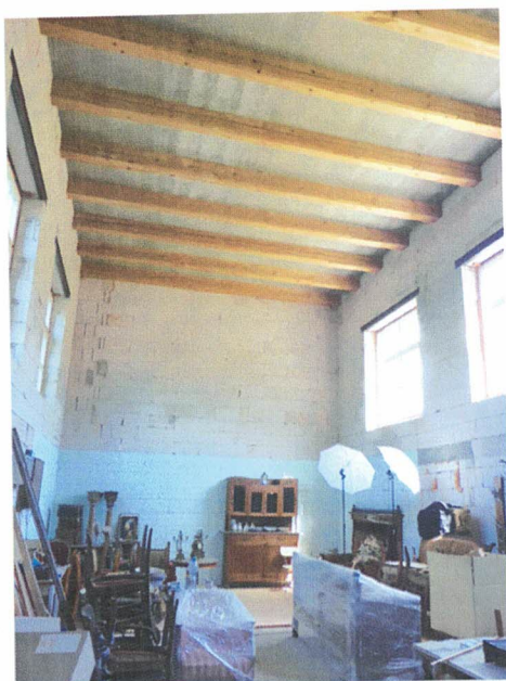
Prostory v přízemní části rozsáhlé přístavby objektu č.p. 111
