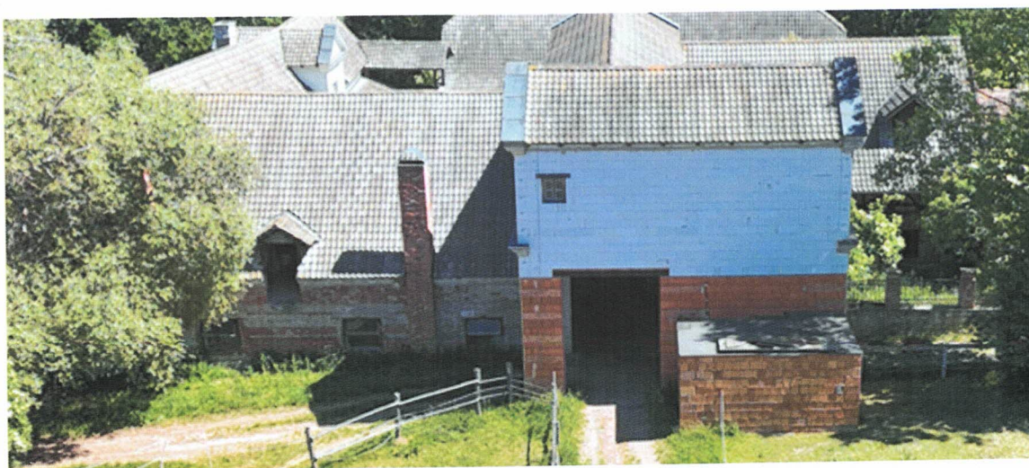
Západní průčelí objektu u západní hranice pozemku parcelní číslo st. 109 s dostavěným západním křídlem zasahujícím do pozemku parcelní číslo 1373.
