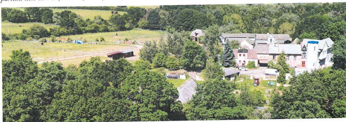
Celkový pohled na území tvořené pozemky a stavbami na nich umístěnými, které tvoří funkční celek, tj. na pozemky parcelní číslo st. 109, st. 145, 1370, 1373, 1388/6 a 1729 v katastrálním území Líčkov, obec Liběšice, okres Louny;
