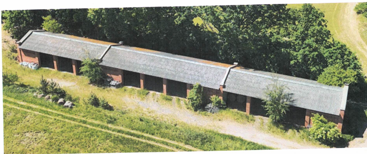
Letecký pohled na seník – východní průčelí stavby
