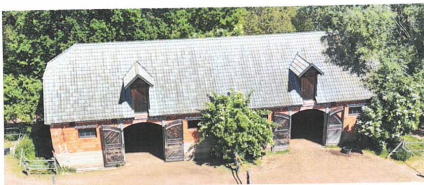
Stavba stájí, která stojí na pozemku parcelní číslo 1373 u pastvin ohraničených ohradami
