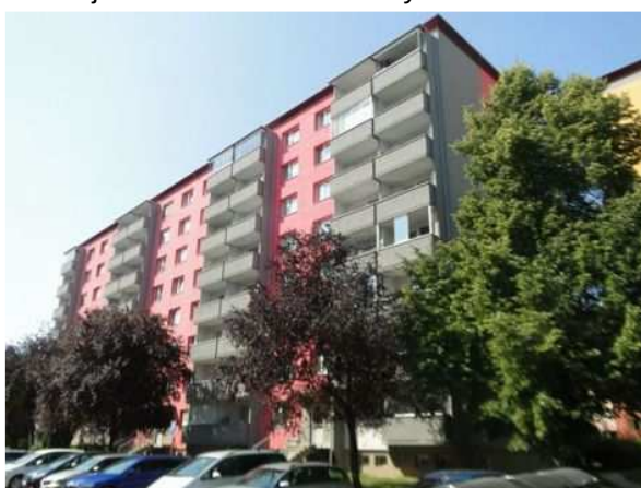
Uliční pohled na bytový dům
