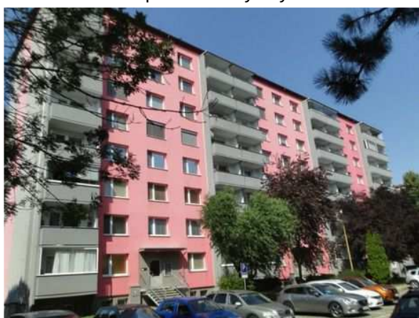
Uliční pohled na bytový dům
