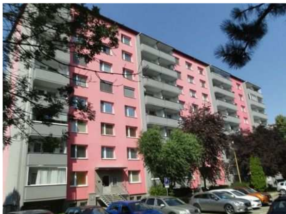
Uliční pohled na bytový dům
